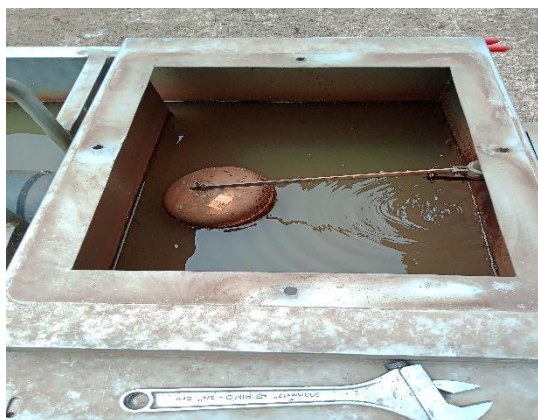
Colocación de boya nueva
