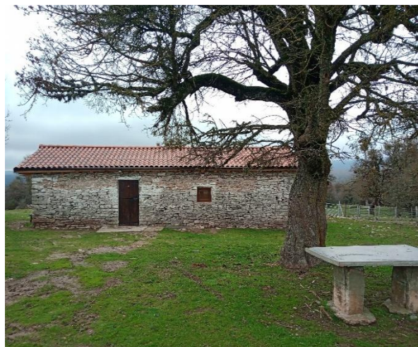
Rehabilitación de chabola en Arratondo
