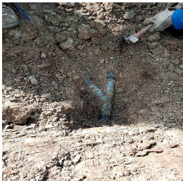
Derivación en conducción del Raso
